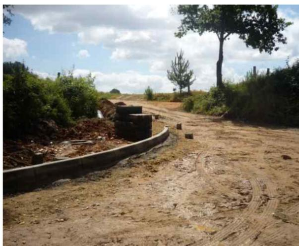
As obras tiveram início em Canelas, na **Rua do Picoto Sul**, onde o piso deteriorado (em macadame) vai dar lugar a uma via pavimentada a tapete betuminoso a quente, havendo ainda uma intervenção ao nível de drenagem de águas pluviais.
