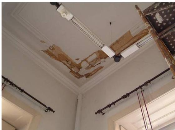
Foram realizados trabalhos de reabilitação interior no edifício dos Paços do Concelho. As obras de conservação foram realizadas a nível de correcção de fissuras nos tectos e paredes, bem como o tratamento e pinturas das carpintarias.
